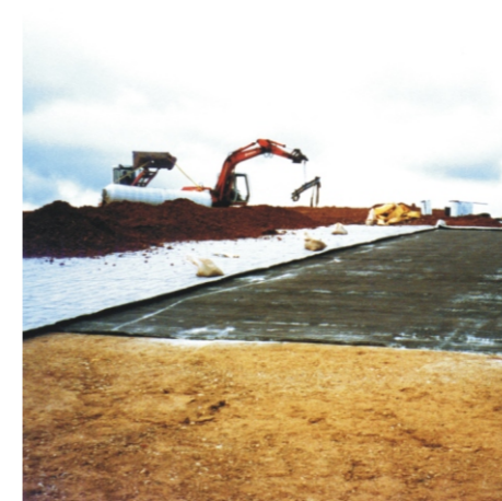
Abdichtung einer Deponie mit Bentonitmatten
