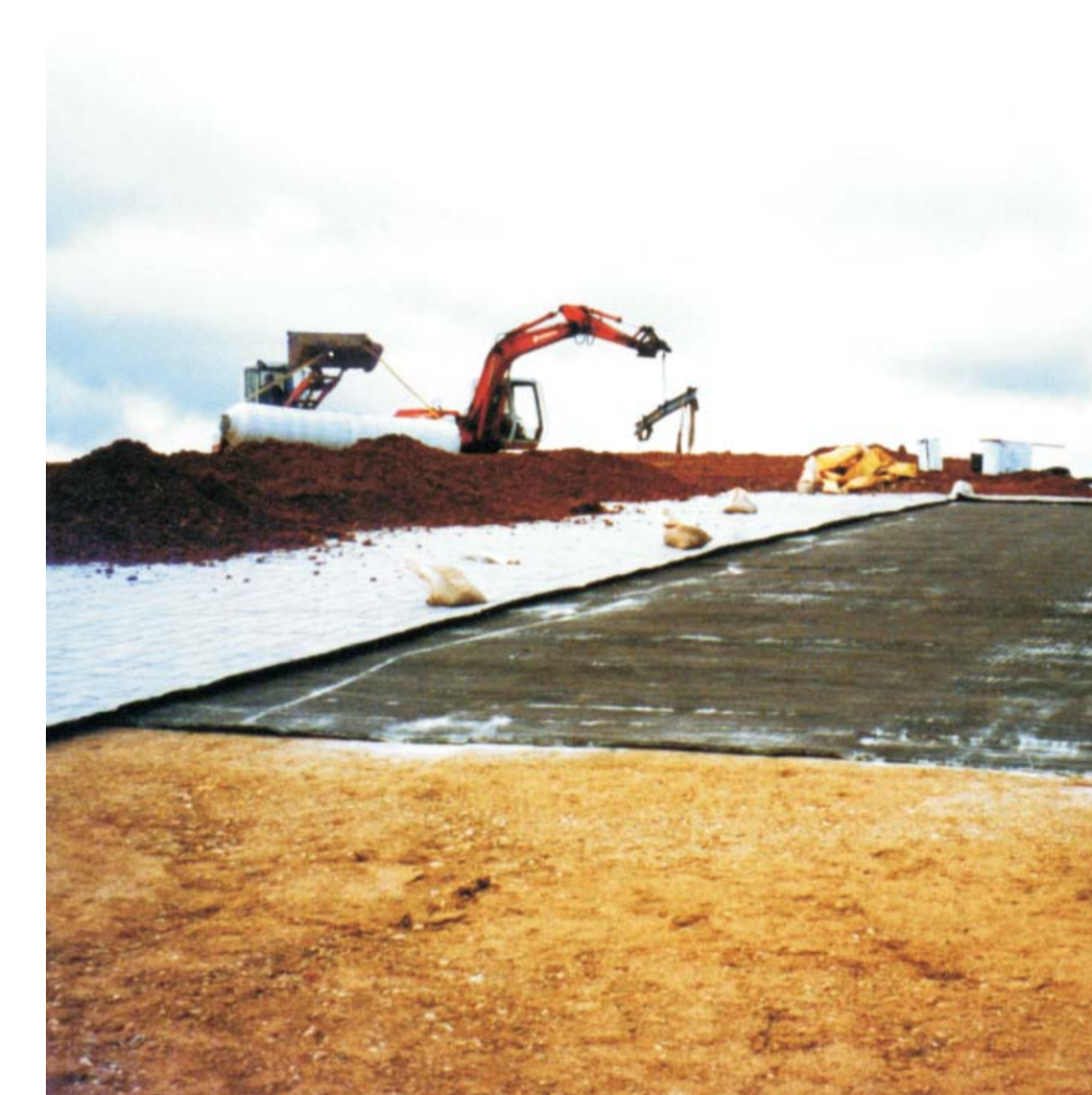
Sąvartyno sandarinimas bentonito kilimu
