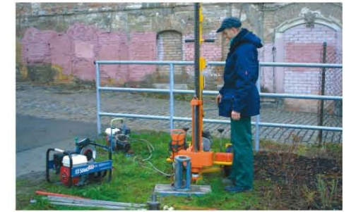
Bestimmung des Verdichtungsgrades und der Tragfähigkeit der Bodenschichten durch schwere Rammsondierung
