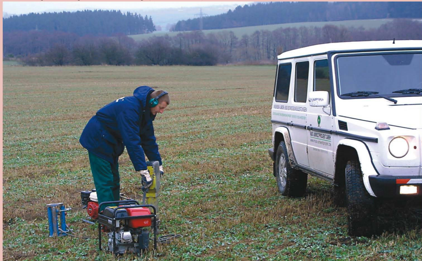
Foto unten: Baugrunderkundung durch Kleinrammbohrungen, Probenehmer Klaus Märtner
