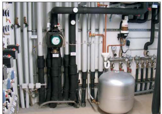
Grundwassernutzung zum Heizen und Kühlen der M&S-Firmenzentrale
